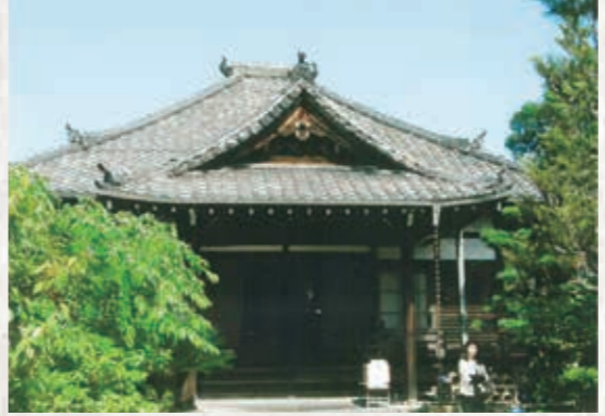
淀・妙教寺 (旧幕府軍の大砲の弾が本堂内の柱を貫通、その砲弾を砲弾跡として保存)
