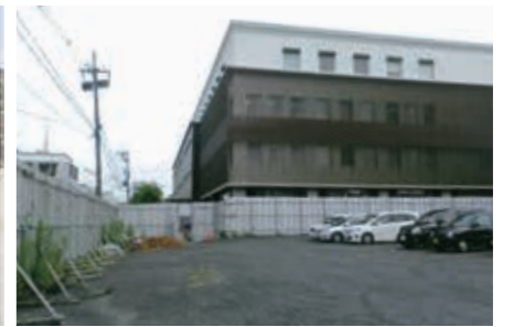
桜・ハナミズキのあった旧伏見総合庁舎の玄関回り
